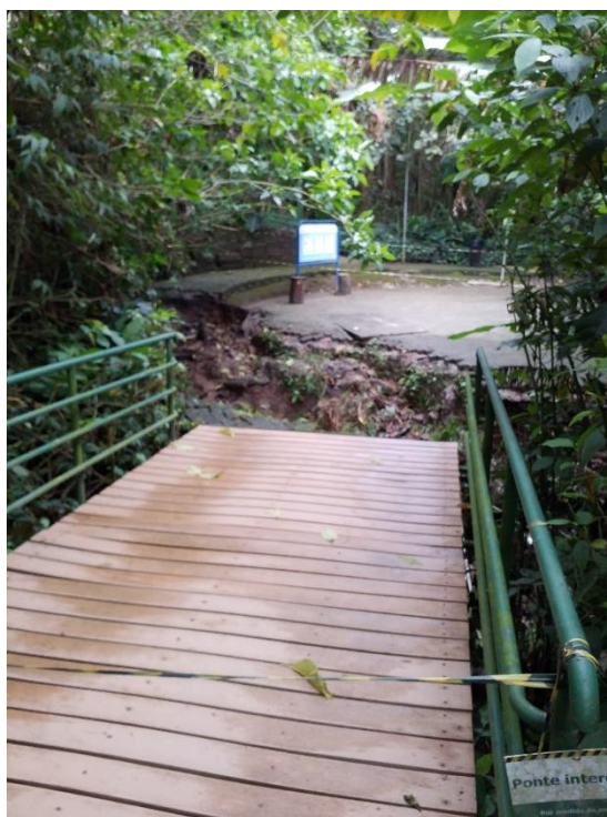
Figura 62 – Erosão do solo (Parque Jardim Herculano)
