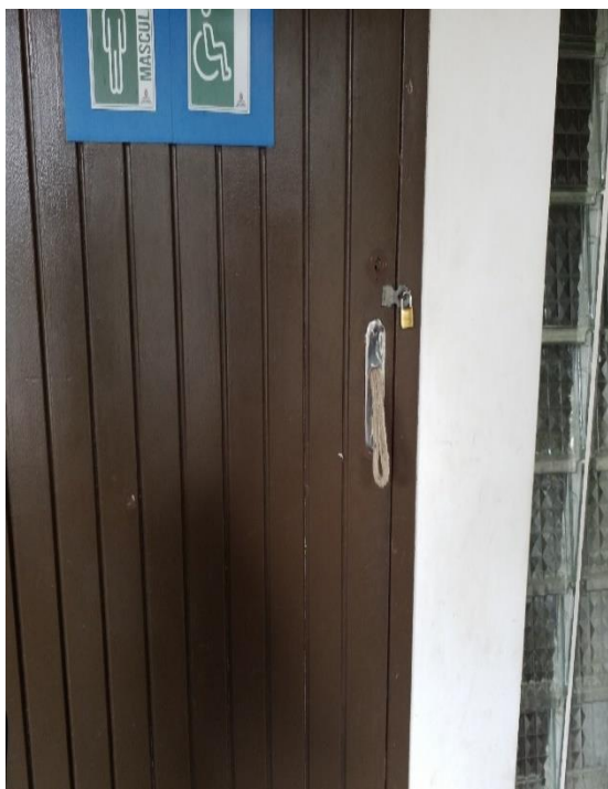
Figura 49 - Sanitário adaptado trancado (Parque do Carmo)
