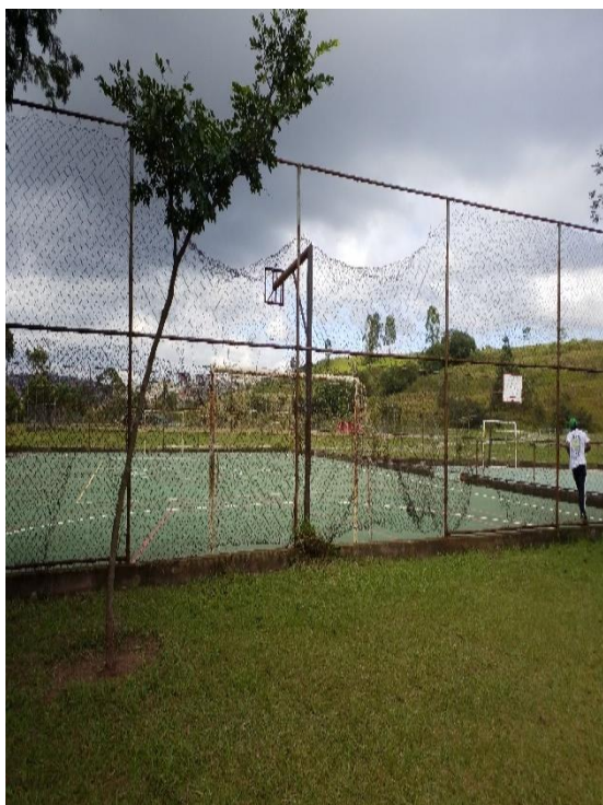
Figura 29 - Quadra mal conservada (Parque Sapopemba)
