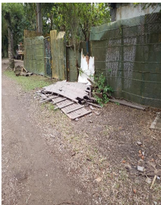
Figura 55 - Entulho (Parque do Carmo)
