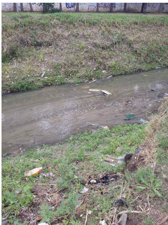
Figura 59 – Resíduos aparentes em corpo d'água (Parque Linear Água Vermelha)
