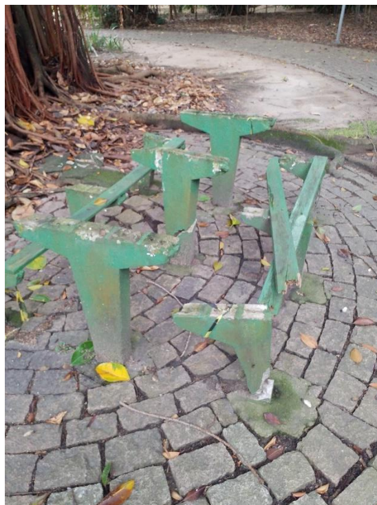
Figura 16 – Banco mal conservado (Parque Piqueri)
