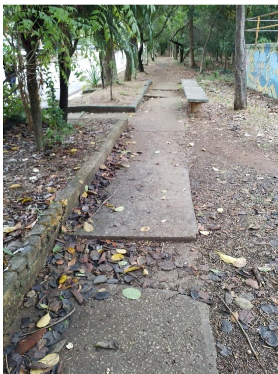
Figura 30 – Espaço para caminhada mal conservado (Parque Linear Tiquatira)
