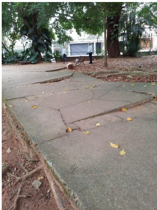
Figura 34 - Espaço para caminhada mal conservado (Parque Severo Gomes)
